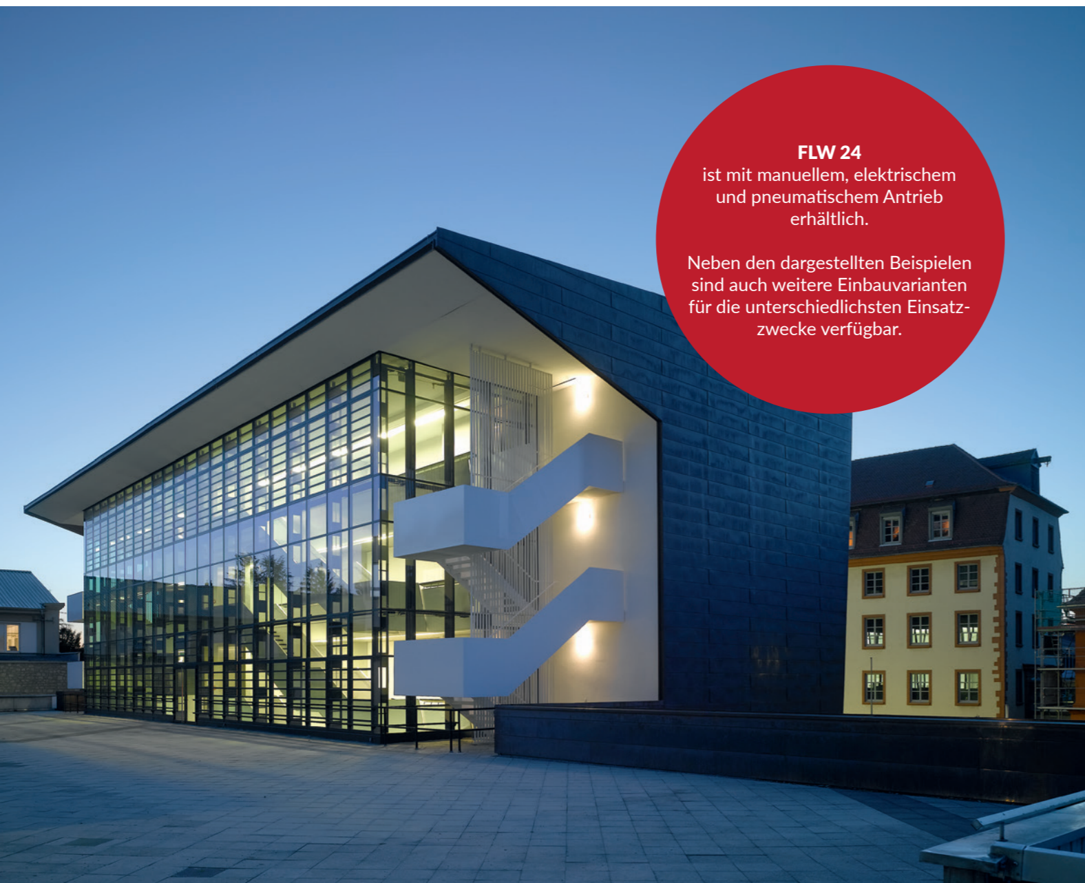
Deutschhaus-Gymnasium Würzburg, Wulf Architekten: Die verglaste Treppenhalle bringt das Licht bis in das Erdgeschoss. Die verbauten Lamellenfenster in der Fassade sorgen für die tägliche Lüftung und dienen zur Rauchableitung im Brandfall.
